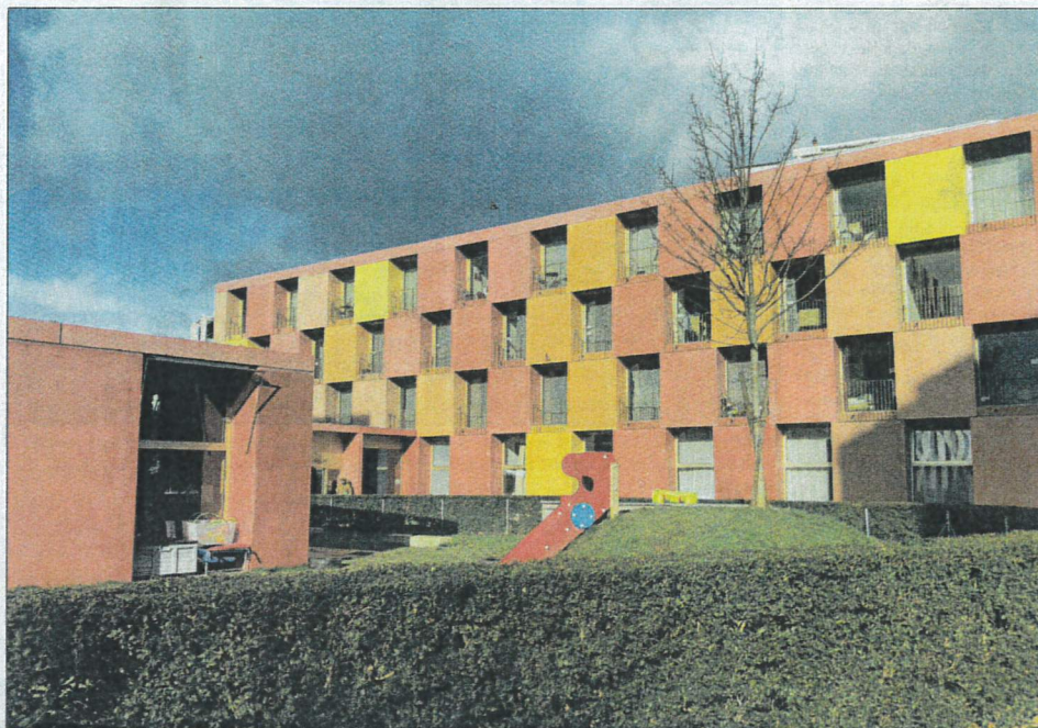
L'ÉTABLISSEMENT LE NOUVEAU PRIEURÉ a fait le pari de la mixité. Outre une crèche avoisinante, le site, qui jouxte le cycle d'orientation de la Gradelle, comprend une résidence pour étudiants et des appartements locatifs, ainsi qu'une résidence pour personnes polyhandicapées.
